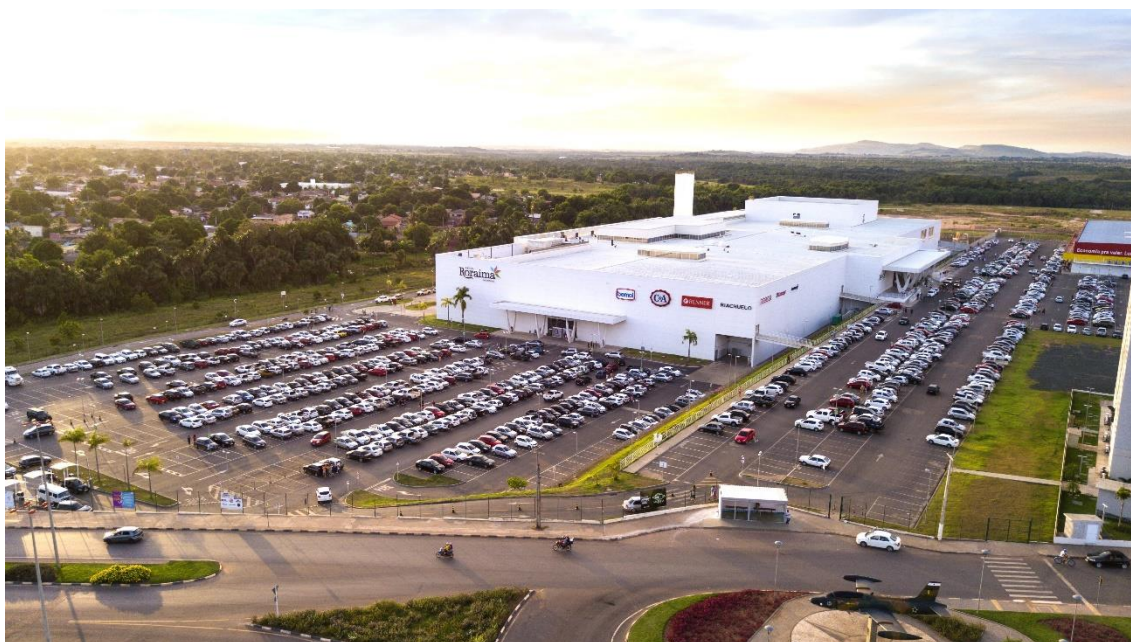
Figura 30: Pátio Roraima Shopping, um Polo Gerador de Viagens de Boa Vista/RR.
