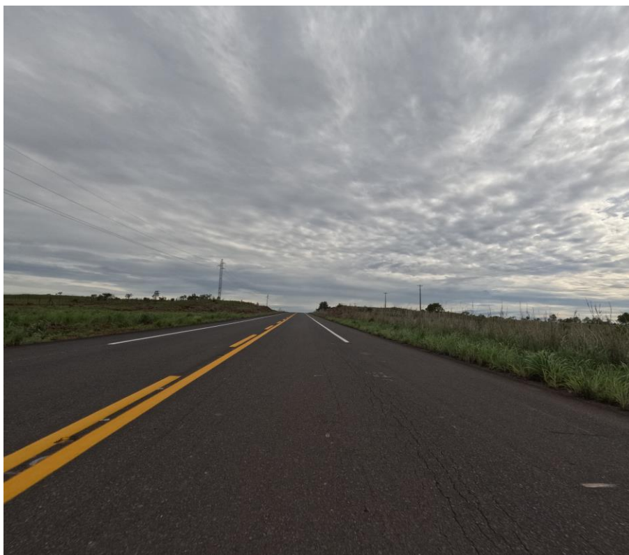
Anel Viário, próximo ao Rio Cauamé
