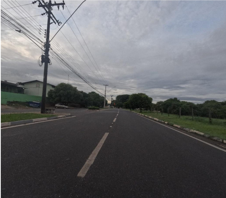
Figura 72: Exemplo de sinalização horizontal em boas condições.
