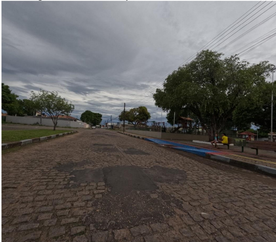
Figura 69: Trecho em calçamento na Rua das Andorinhas.
