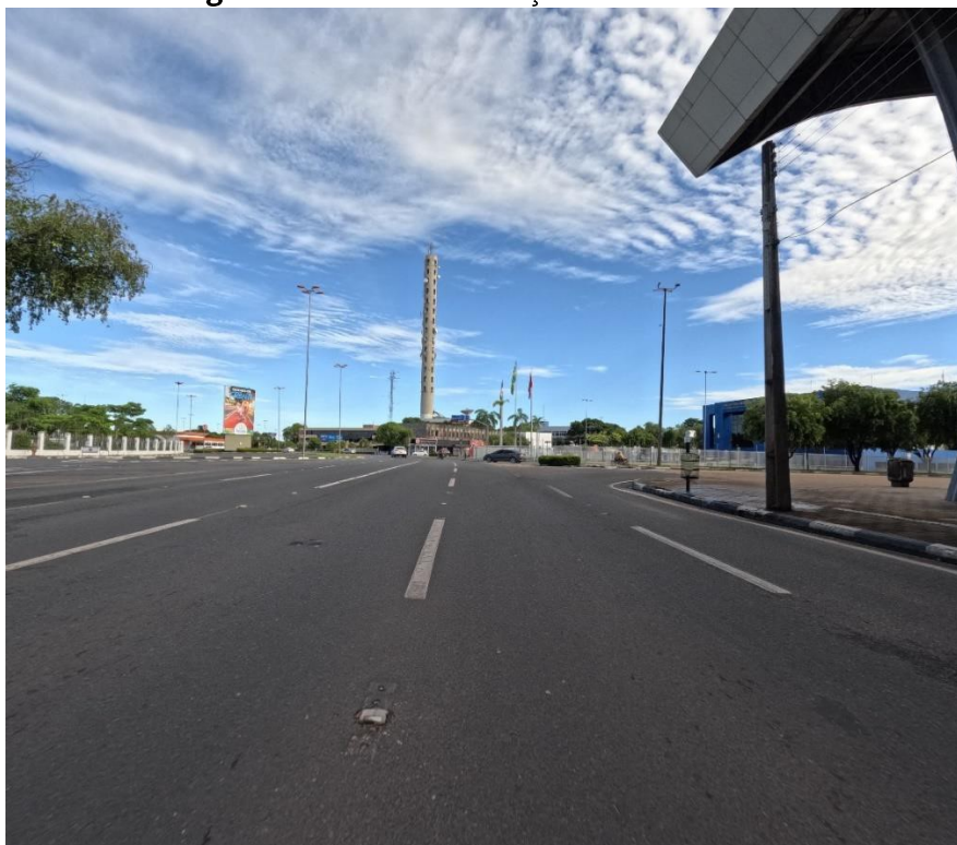
Figura 80: 5 faixas na Praça do Centro Cívico.
