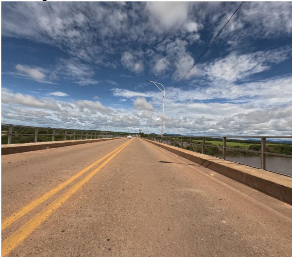
Figura 67: Trecho de concreto sobre a Ponte dos Macuxis.
