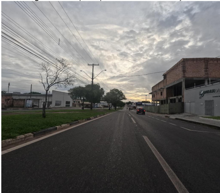
Figura 64: Exemplo de pavimento em boas condições.
