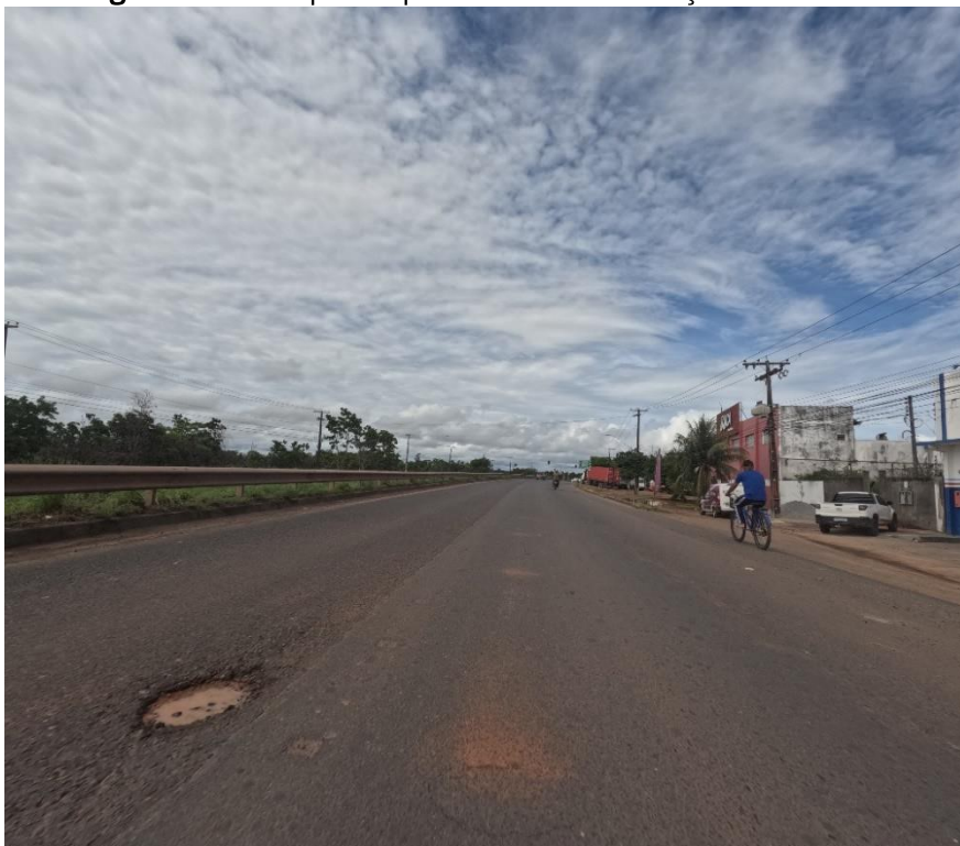
Figura 65: Exemplo de pavimento em condições razoáveis.
