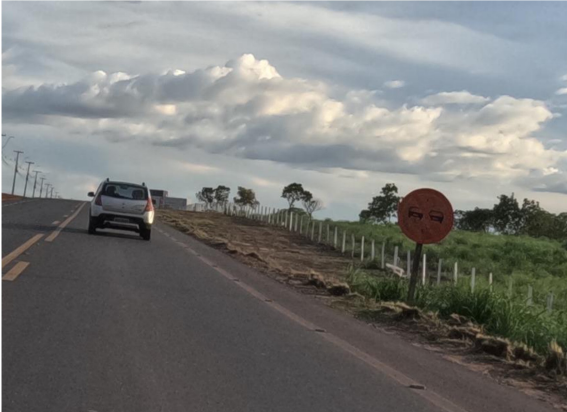
Figura 78: Exemplo de sinalização vertical em condições ruins.
