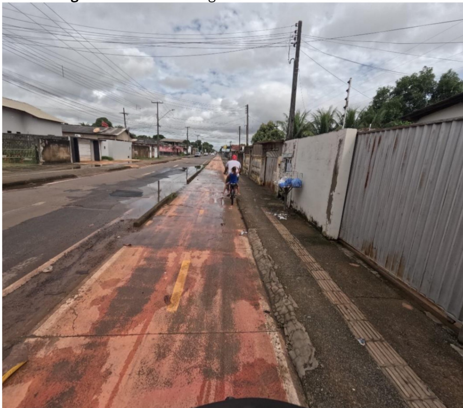
Figura 45: Ponto de alagamento na Rua Mestre Albano.
